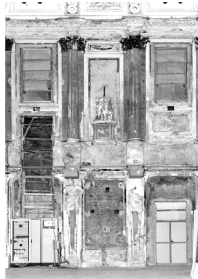
Figura 9. Prima dell'ultimo intervento
