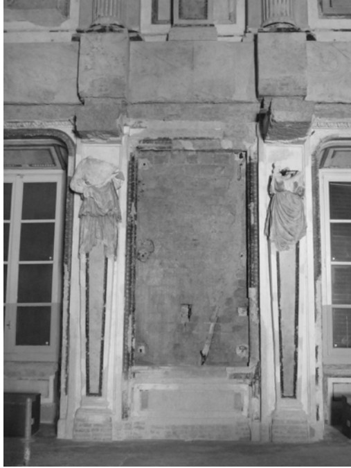
Figura 15. la stessa zona della figura 8 dopo il restauro
