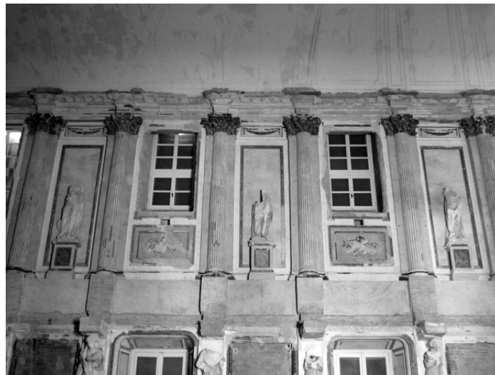
Figura 14. la parte alta della parete Ovest, dopo il restauro
