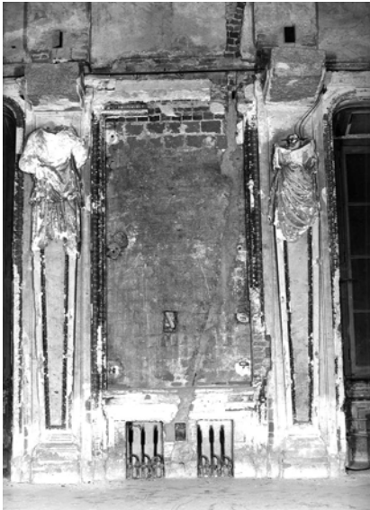
Figura 8. Prima dell'intervento di restauro del 2000
