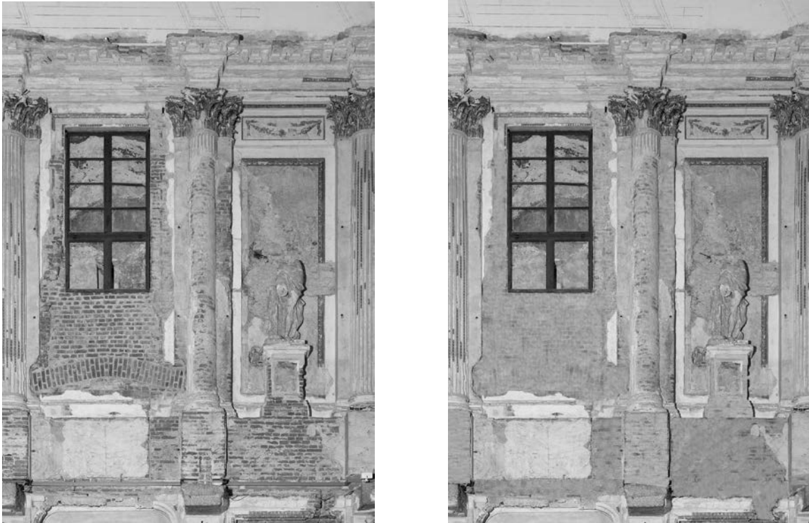
Figure 10 e 11. le campate 19 e 20 prima del restauro e dopo le prove di trattamento dei mattoni a vista
