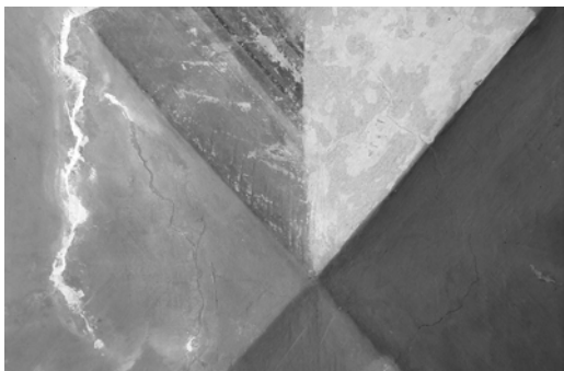
Volte della navata e del transetto sinistro; nel tassello stratigrafico si riconoscono: la coloritura novecentesca monocroma, la decorazione ottocentesca che riquadra le volte, la coloritura chiara monocroma, più antica
