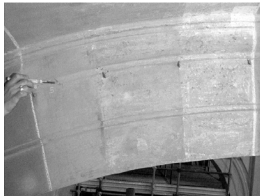
Dettaglio stratigrafico di una delle arcate: a partire da sinistra coloritura novecentesca, colorazione bruna ottocentesca, finitura a finto marmo grigio cerulea
