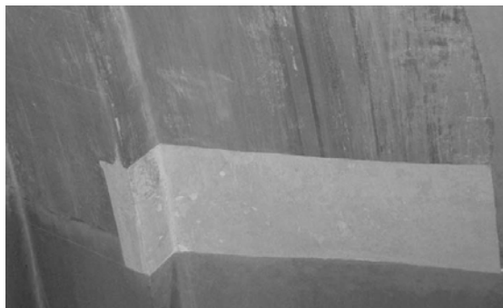
Volte della navata e del transetto sinistro; nel tassello stratigrafico si riconoscono: la coloritura novecentesca monocroma, la decorazione ottocentesca che riquadra le volte, la coloritura chiara monocroma, più antica
