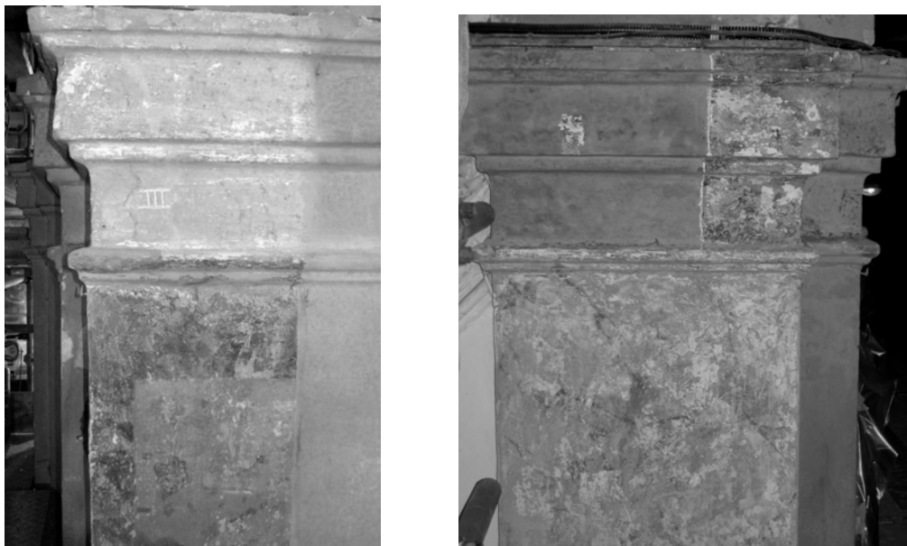
Pilastri: nei fusti la prova di pulitura mette in luce una delle tinteggiature ottocentesche
