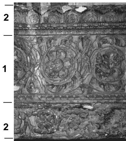
Fig. 1b. Dettaglio dell’architrave: 1) marmo greco, 2) calcare di San Giuliano
