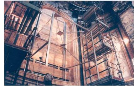
Le aste di sollevamento sono misurate per scendere a quota terra (380 cm.) allontanandosi gradualmente dalla parete e oltrepassando l'ingombro dell'altare (360 cm). L'operazioni di aggancio del telaio alla struttura hanno preceduto le fasi di movimentazione automatica condotta da un solo operatore.
