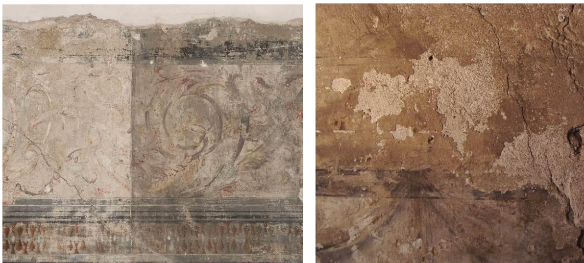
Figure 10 e 11. A sinistra, tassello di pulitura sul fregio della parete destra. A destra, la concrezione di deposito, incrostazione e fissativo sulla parete centrale. Le lacune più chiare corrispondono alla caduta della crosta superficiale, che rende visibili gli strati decoesi sottostanti.
