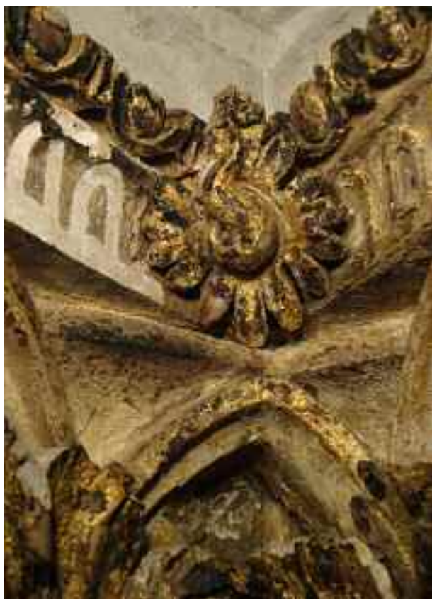
Fig. 5. Uno dei capitelli all'angolo Nord-Est, con carbonizzazione degli strati preparatori alla doratura e sollevamenti della pittura nei fondi.
