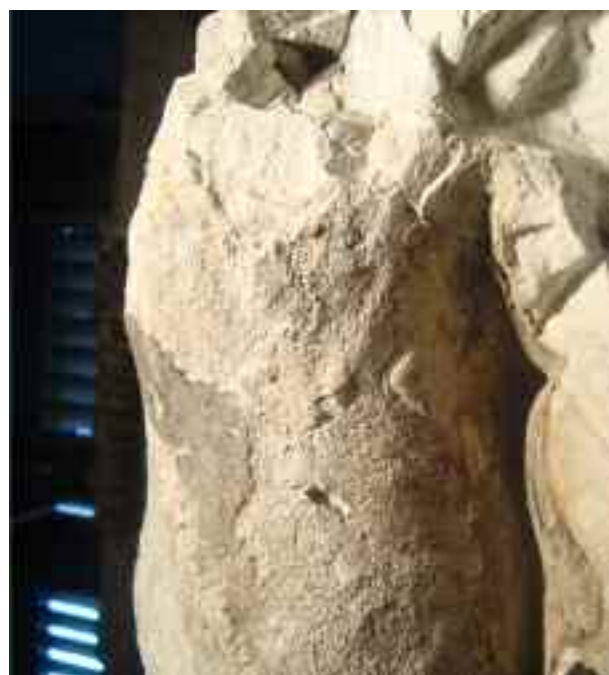
Fig. 20. Decoesione dello stucco su una delle cariatidi all'angolo tra parete Est e Nord.
