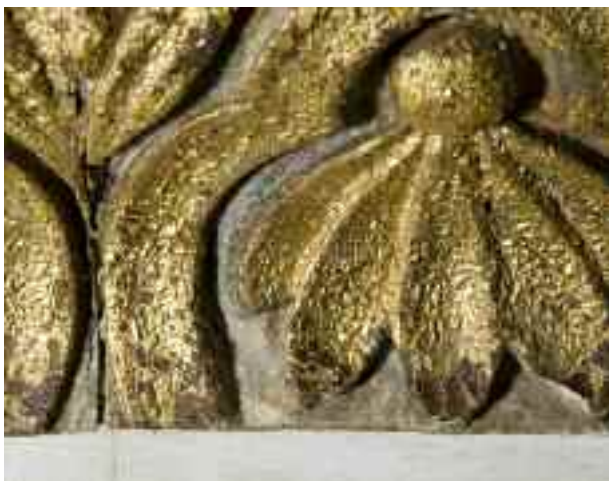
Fig. 26. Sollevamenti della foglia d'oro su una delle cornici (foto di M.Ranzani).
