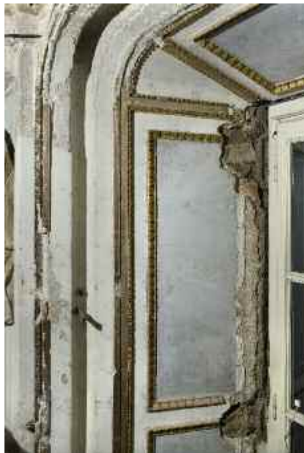
Fig. 33. Esempio degli scassi praticati per sostituire gli infissi delle finestre nell'ordine inferiore (foto di M. Ranzani).
