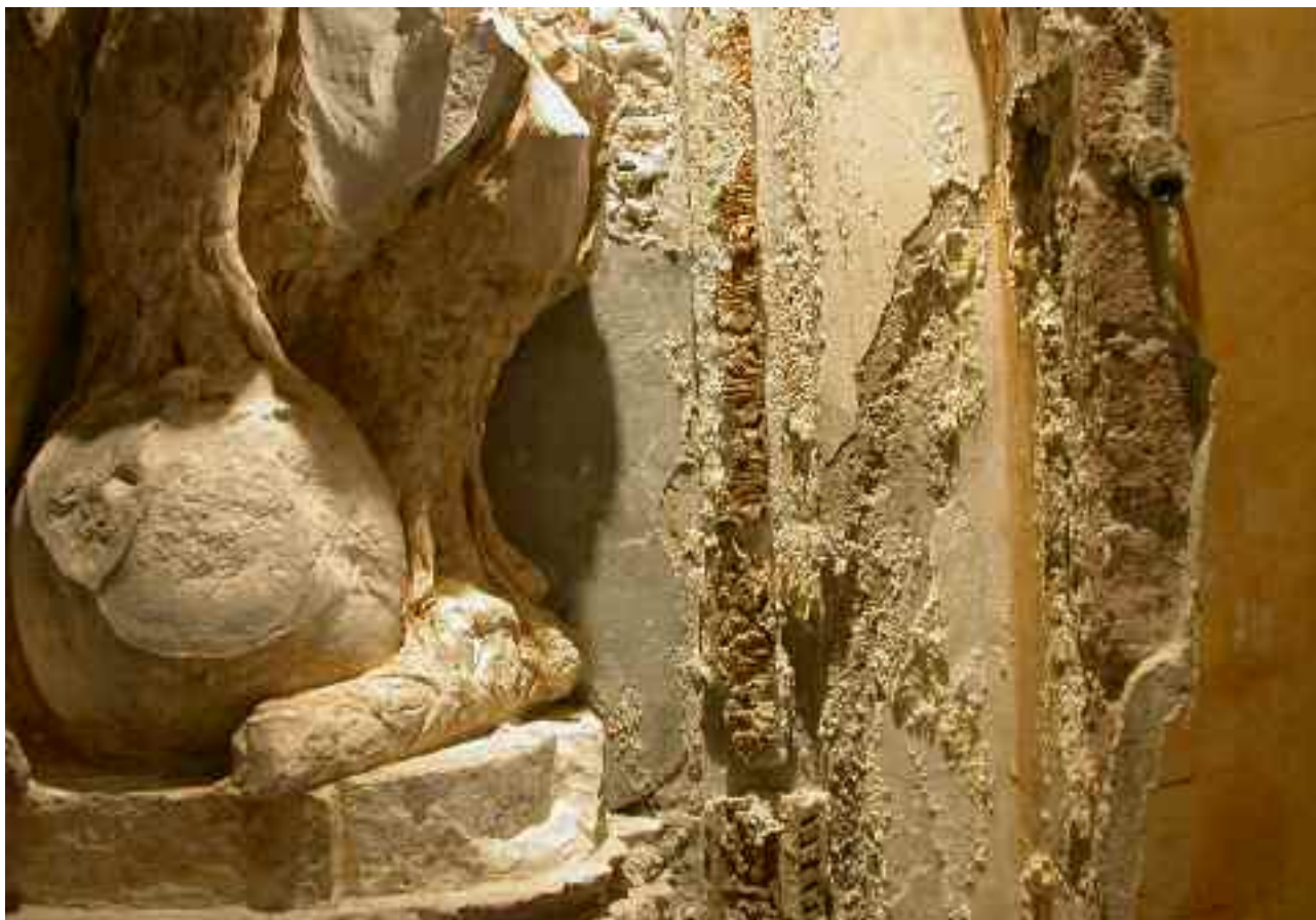
Fig. 22. Particolare dell'affioramento dei sali a lato della statua centrale della parete Sud.
