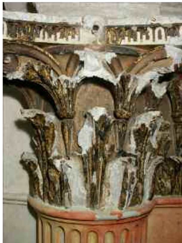
Fig. 27. Nei capitelli si rintracciano riprese a colore dei fondi tra le foglie e doppi strati di doratura sulle decorazioni in oggetto.
