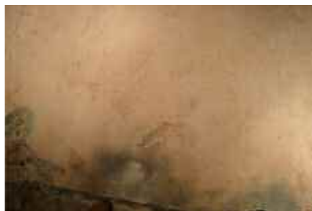
Fig. 3. Tracce di bruciatura su uno dei marmorini rosa del fondo del ballatoio.
