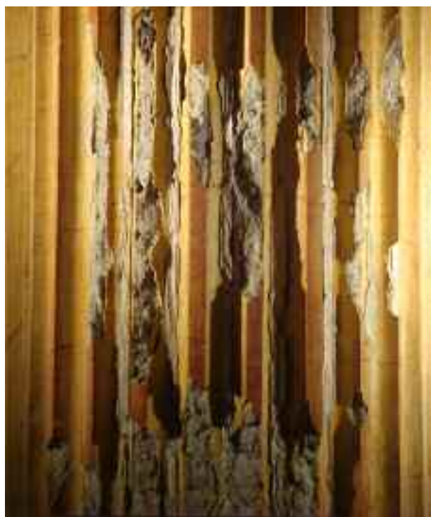
Fig. 25. Cadute e sollevamenti del marmorino di finitura di una delle colonne.
