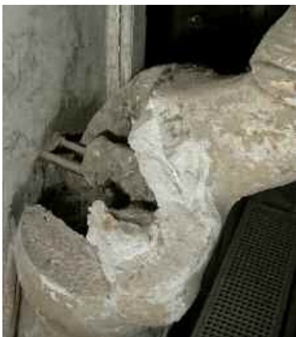
Fig. 13. Particolare dei depositi su una delle cariatidi della parete Ovest.
