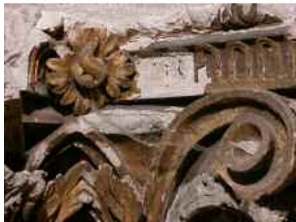
Fig. 12. Particolare prima del restauro di uno dei capitelli dorati della parete Est, ricoperto da una fitta ragnatela.
