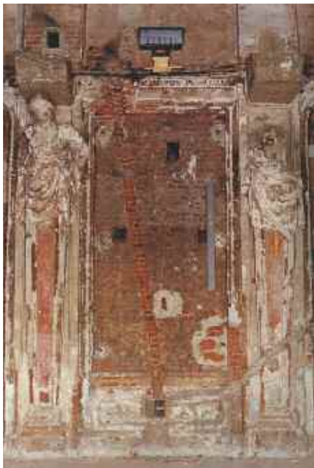
Fig. 34. Uno dei vani degli specchi sulla parete Ovest negli anni '90, dopo gli ultimi adeguamenti impiantistici (foto Archivio Soprintendenza per i beni architettonici e paesaggistici di Milano).
