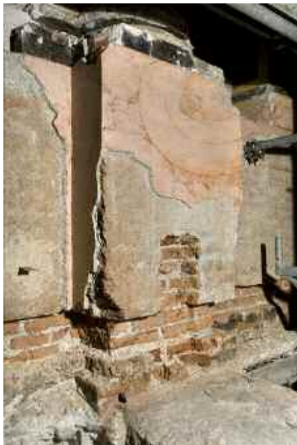
Fig. 35. Particolare degli scassi eseguiti dopo il 1973 all'altezza del ballatoio per sistemare l'impianto di illuminazione (foto di M. Ranzani).
