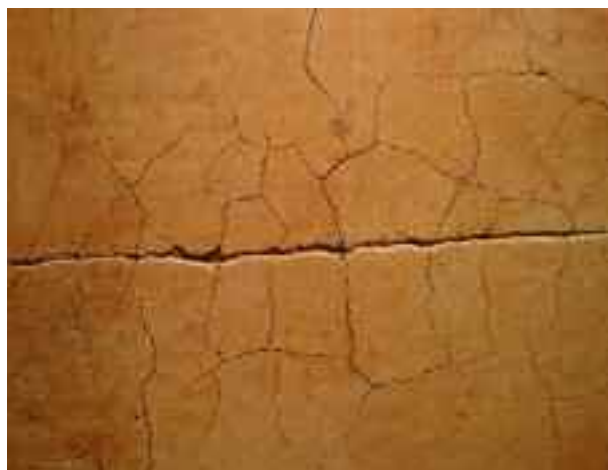
Fig. 24. Profonda crettatura con sollevamento delle plaghe sul marmorino di una lesena.
