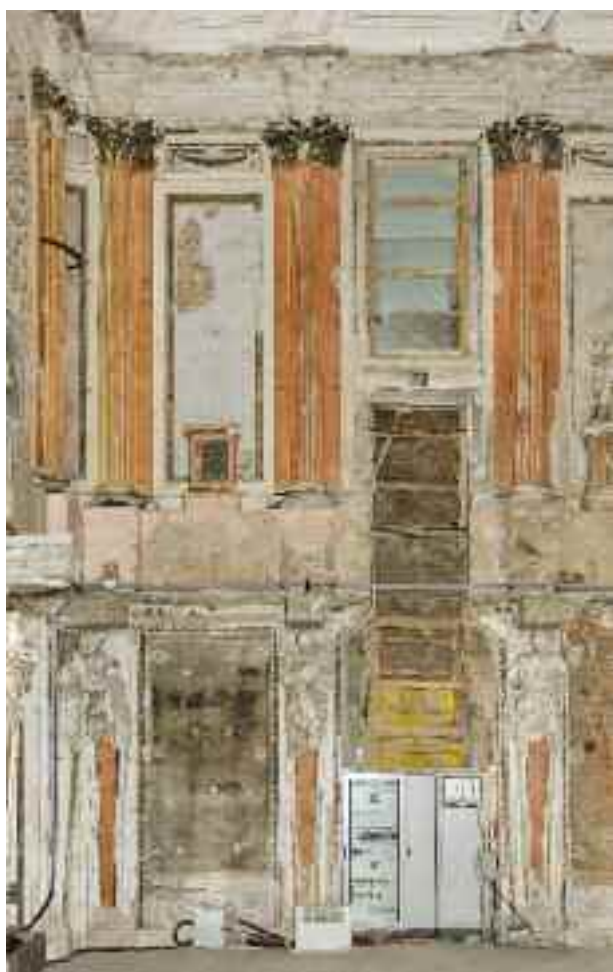
Fig. 42. Parete Nord prima dell'attuale intervento di restauro delle superfici.
