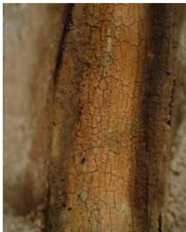
Fig. 28. Particolare a forte ingrandimento del pannello di una delle cariatidi della parete Nord, con la tinta aranciata di finitura.
