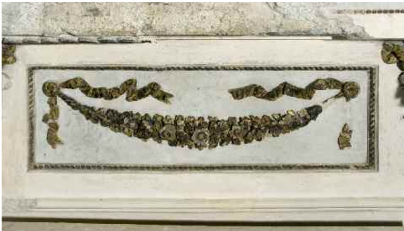
Fig. 4. Uno dei festoni della parete Nord. Le zone scure nelle decorazioni dorate corrispondono alla carbonizzazione dello strato di missione e all'alterazione dello stucco (foto di M. Ranzani).
