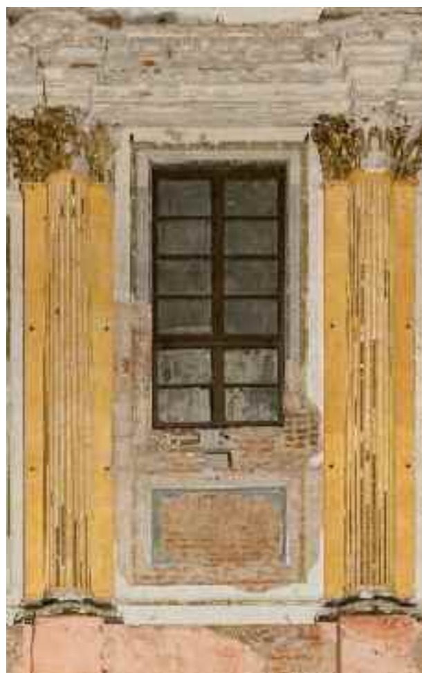
Fig. 43. La finestra cieca della parete Sud, prima del restauro (foto di M. Ranzani).
