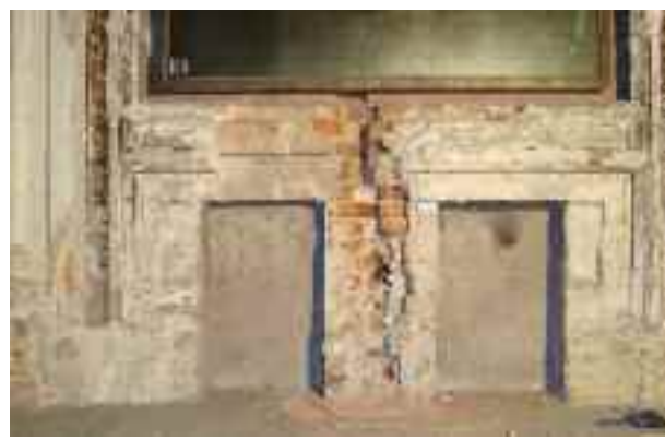
Fig. 19. Scassi creati per la sistemazione degli impianti sotto uno degli specchi della parete Ovest.
