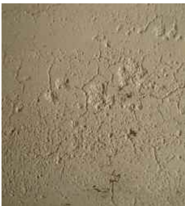
Fig. 23. Abrasioni e microcadute sulle fasce bianche intorno alle formelle dell'ordine superiore, parete Est.
