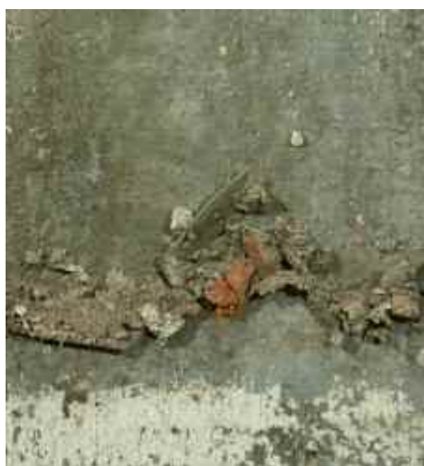
Fig. 14. Dettaglio a forte ingrandimento dei residui di malta, mattone e vetro trovati sotto gli infissi delle false finestre della parete Sud.
