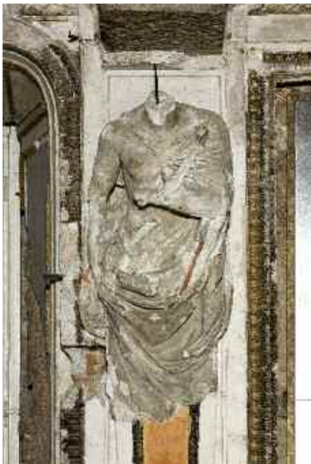
Fig. 32. Cariatide della parete Est. La cornice dorata e la lesena a sinistra sono interrotte dal profondo scasso per l'ammorsatura del ponteggio del 1947 (foto di M. Ranzani).
