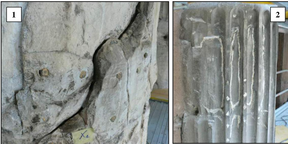
tenuta. Solo nelle colonne 1 e 2 abbiamo rilevato una serie di fori da trapano e un uso per iniezione della resina non caricata.
