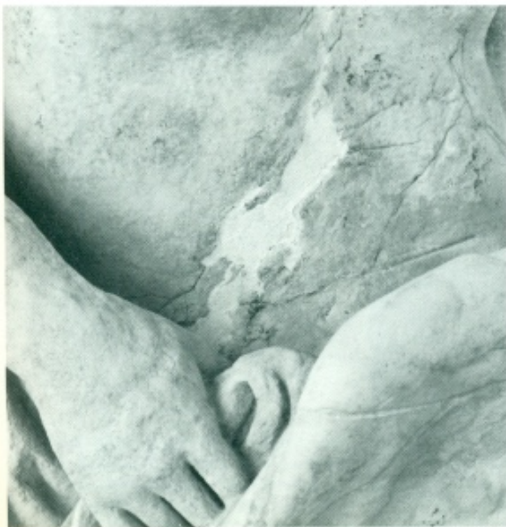
44 - Intervento di restauro. Stuccatura e microstuccatura. Risarcimento di una fessurazione (part. della Atia).
