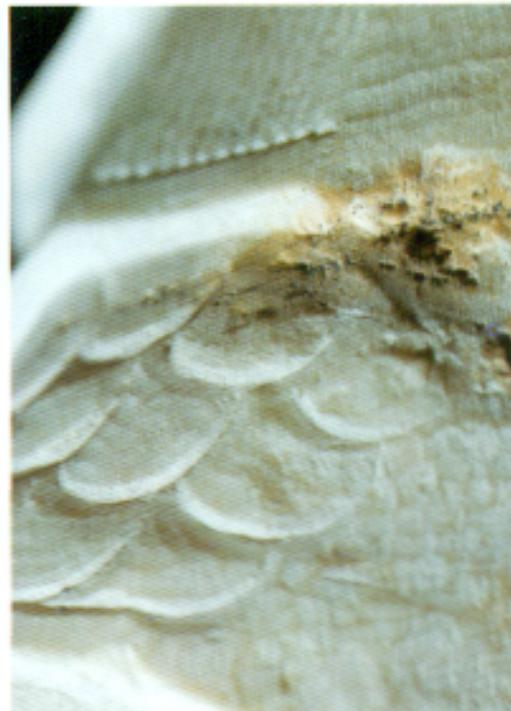
Fig. 4. Corazza: disomogeneità del marmo, inclusioni di ossidi di ferro
