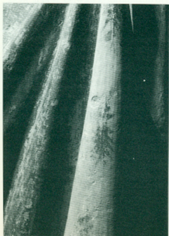
3. Lavorazione della superficie con uno scalpello a taglio smussato (piega del sottomanto).
