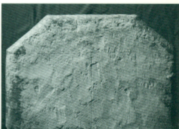
8. Tracce di lavorazione a gradina e incisioni geometriche (faccia superiore del capitello).
