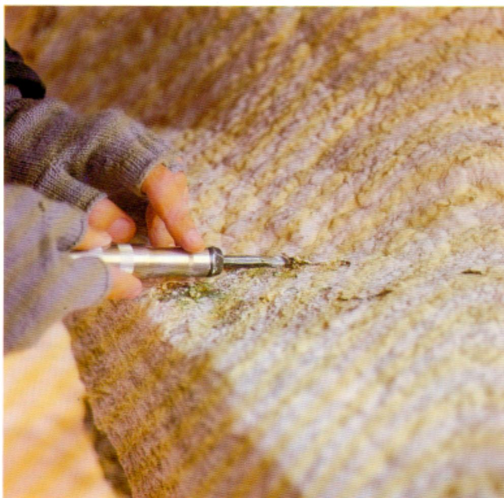
Fig. 11 - Metodi di asportazione del calcare. Particolare del piccolo scalpello ad aria compressa (fotografia CBC)
