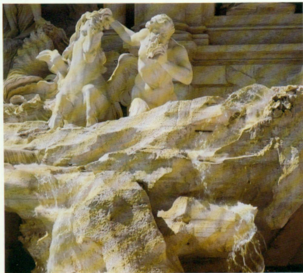
Fig. 8 - La piccola grotta dopo la totale rimozione del calcare (fotografia P. Rizzi)
