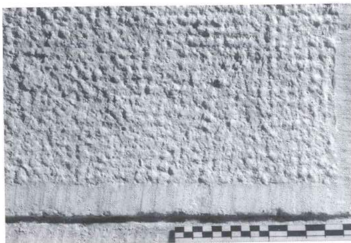
2°Ordine, sottarco tra le colonne 9 e 8*, blocco in marmo di Carrara con lavorazione a bocciarda sul fondo e rifinitura a scalpello dei margini.
