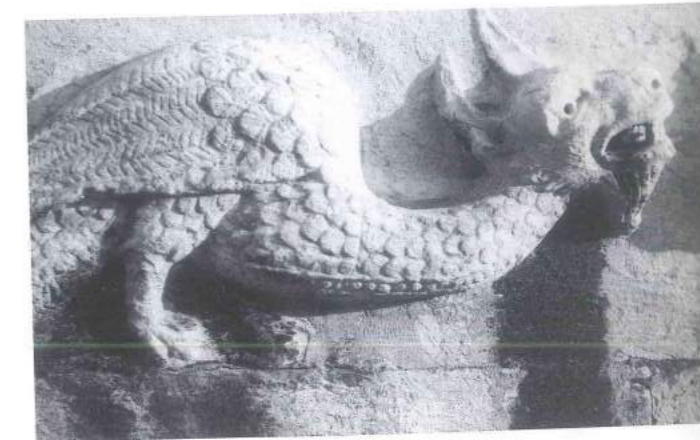
1° Ordine, a destra della porta di ingresso alla Torre, rilievo con mostri marini in marmo di S.Giuliano, lavorazione a martellina del fondo, evidente soprattutto sotto il collo del drago.
