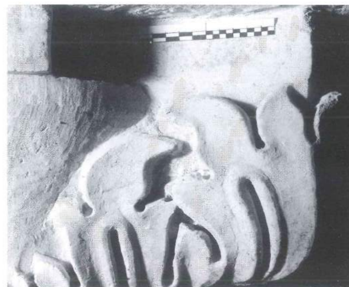
2° Ordine, fronte esterno del capitello 8, lavorazione a scalpello e a trapano. Nel fondo, tra i lobi delle foglie, si indovina qualche traccia della iniziale sgossatura a subbia.
