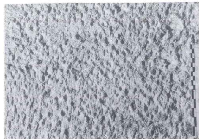
1° Ordine, strombo della finestra del tamburo, segni di lavorazione a gradina.
