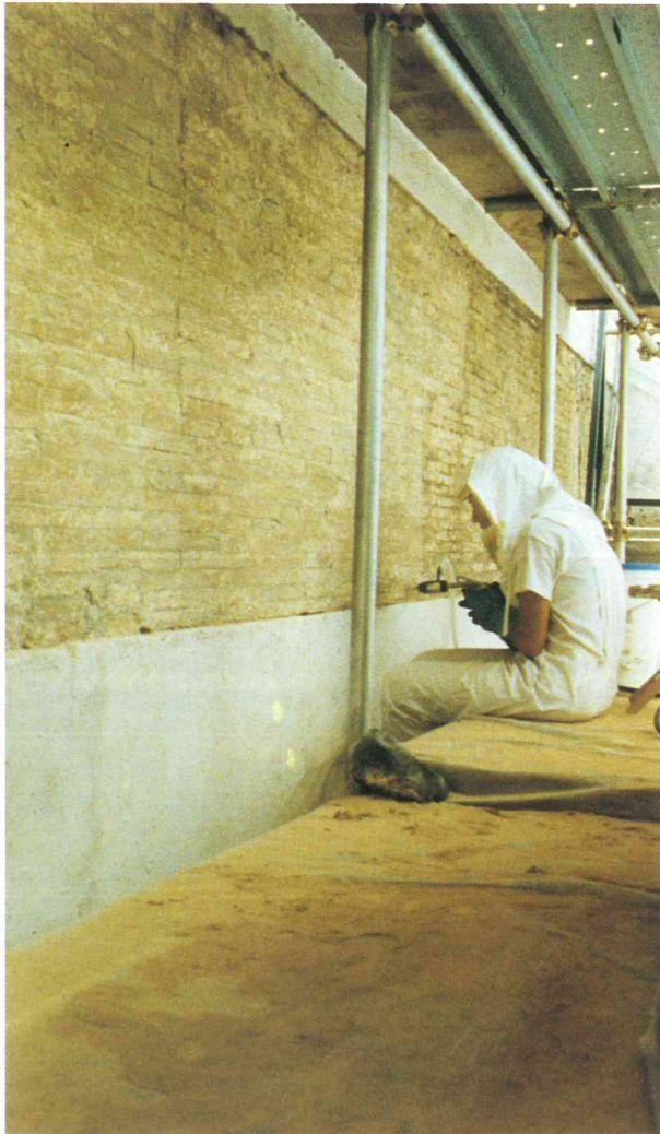
12 Microsablage de précision sur la courtine de la vasque.
