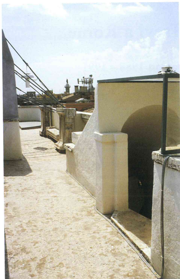
2 Terrasse après restauration.
