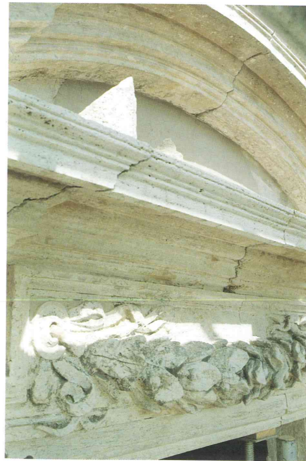
10 Éléments architecturaux en travertin après restauration.
