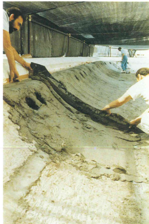
13 Réalisation du manteau imperméabilisant de la vasque.
