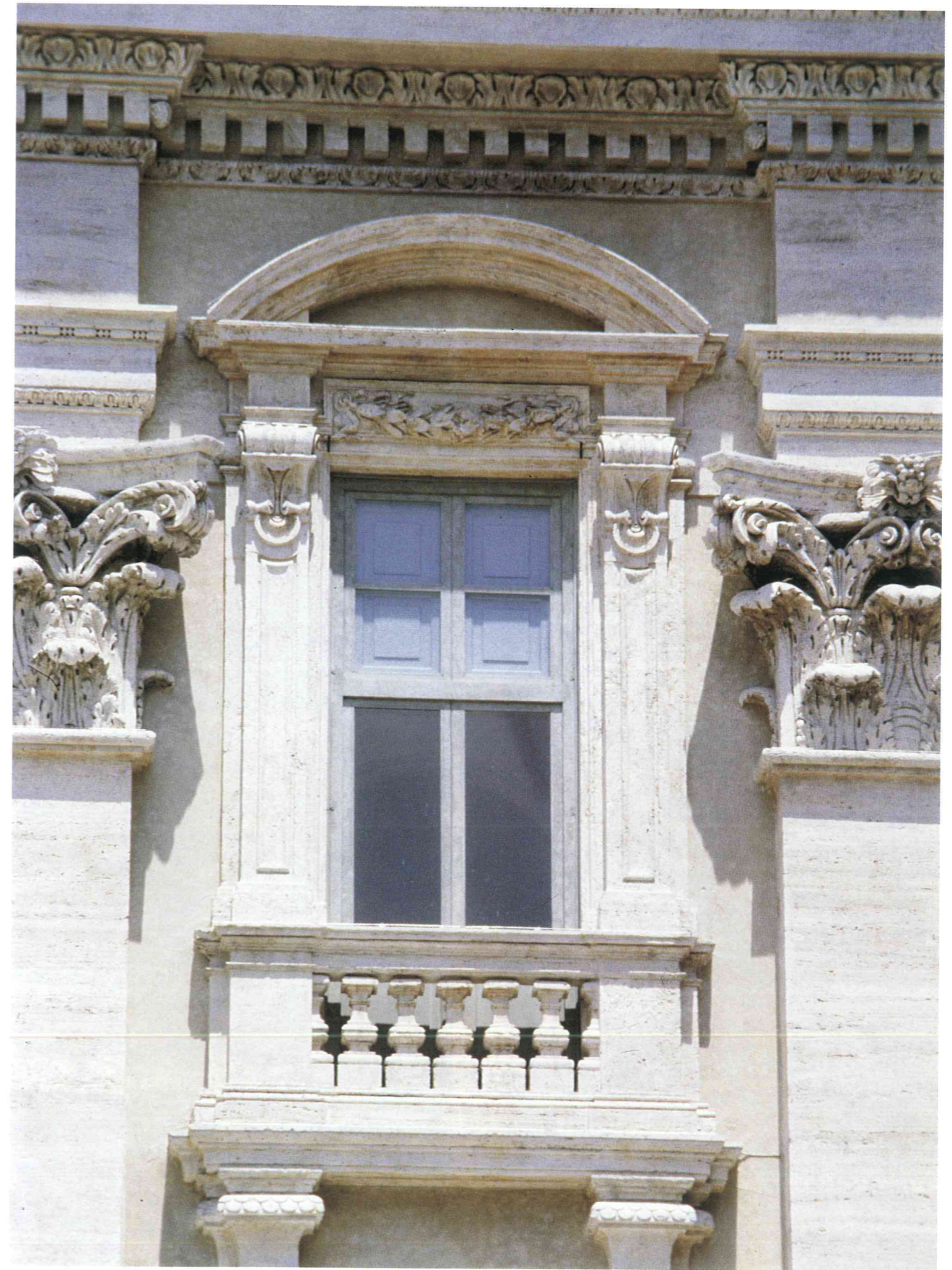
8 Nouveaux cadres de fenêtres réalisés en trompe-l'œil.
