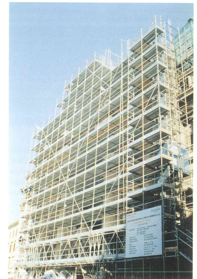
1 Partie centrale de l'échafaudage.
