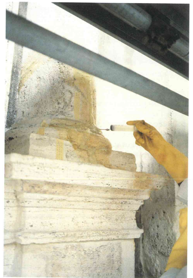
11 Injection de produit consolidant.
