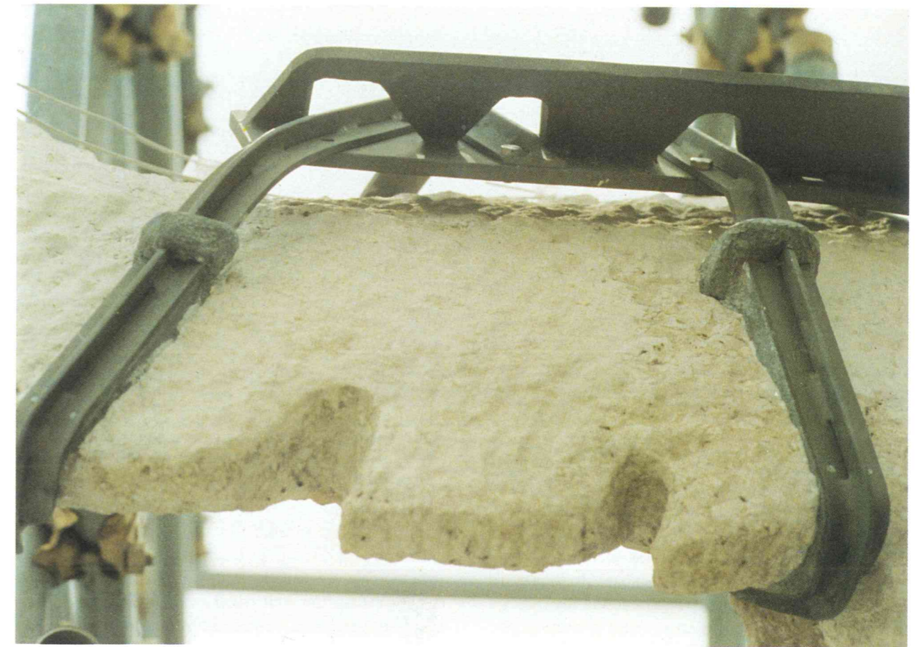
6 Groupe sculptural de l'attique: détails de la nouvelle structure en titane.
