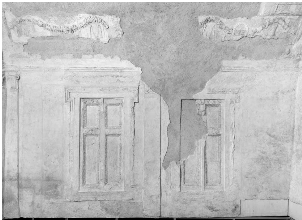
Figura 16. La parete ovest e parte della volta al termine del restauro; la stuccatura della grande lacuna è stata condotta contestualmente su volta e parete per evitare interruzioni nella lavorazione e nei tempi di asciugatura.
