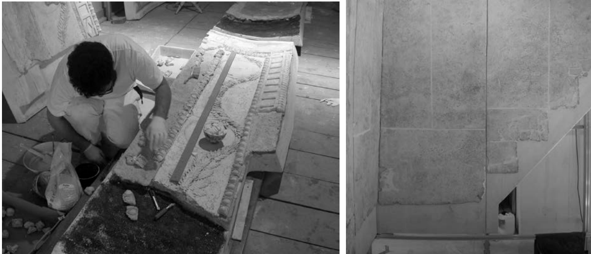
Figure 12 e 13. La ricerca e il ricollocamento dei frammenti erratici e la stuccatura degli stucchi montati sui pannelli di supporto. La parete sud rimontata sulla struttura di sostegno: le stuccature dei giunti all’interno di ogni pannello e quelle ancora da eseguire tra un pannello e l’altro.
