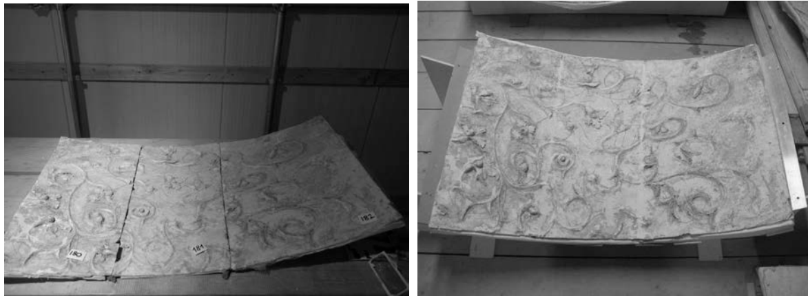
Figure 10 e 11. La stuccatura del fronte eseguita su ciascun settore a risarcire lacune dei piani di fondo e del rilievo; la stuccatura delle giunzioni dei settori che compongono un pannello di supporto
