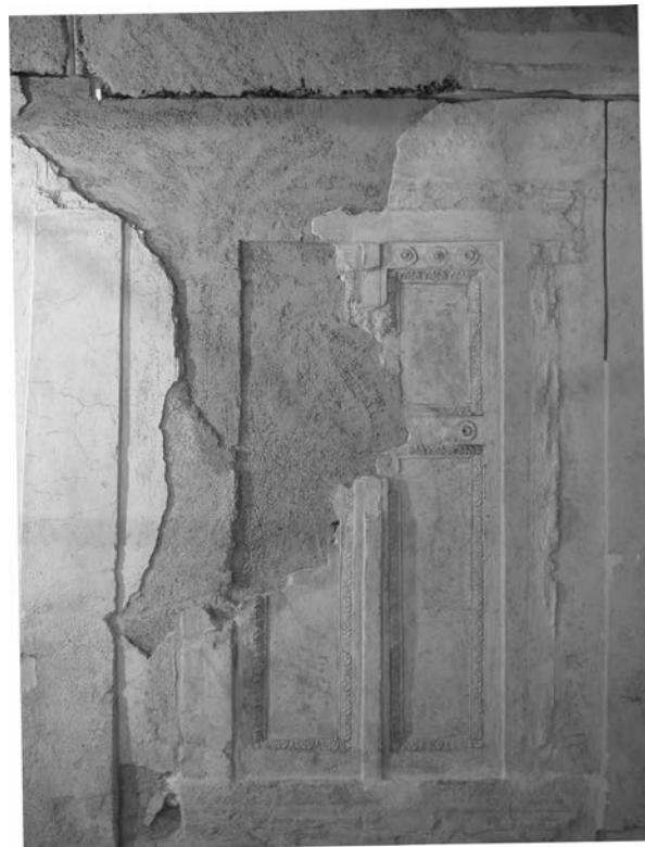
Figura 15. Con il rinzaffo è suggerito il diverso piano del battente della finta porta rispetto alla parete di fondo e allineata la quota del sottolivello rispetto a quella dei pannelli contigui.
