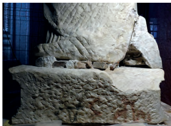
24 – GIAN LORENZO BERNINI: SANTA BIBIANA (PARTICOLARE) VEDUTA LATERALE DELLA COLONNA DURANTE L'ASPORTAZIONE DELLA STUCCATURA IN GESSO NEL CANTIERE DI RESTAURO ALLA GALLERIA BORGHESE (foto di Mark Gittins)
